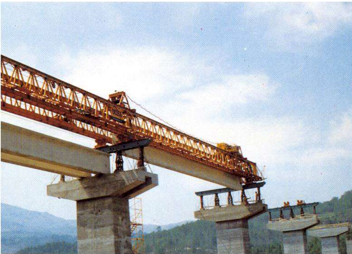
Colocacion de losa sobre viga presforzada.
