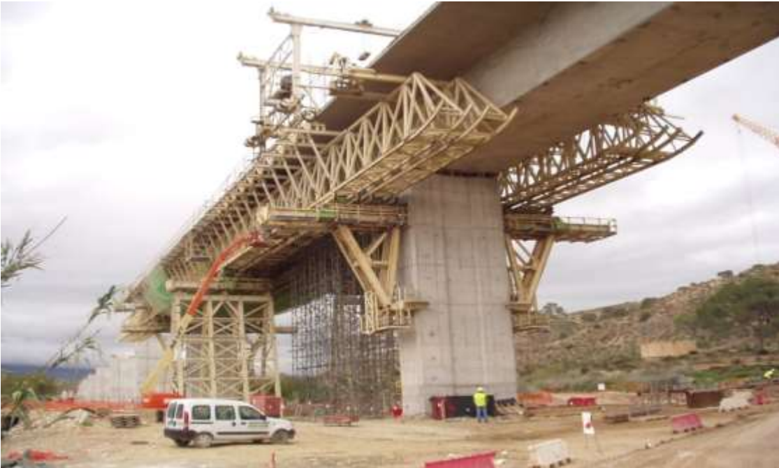
Viga presforzada en el proceso de ejecución.
