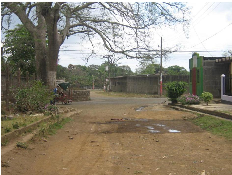
**Fig. 10 Cuneta existente en la mitad del tramo y que no establecen el ancho mínimo de la vía.**
