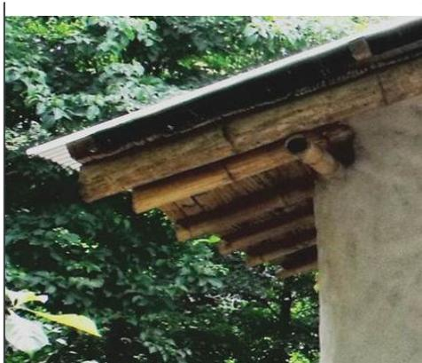
**Cubiertas:** los clavadores deben ser de forma que transmitan las cargas, tanto verticales como horizontales deben anclarse a la solera o viga corona que sirve de amarre de los muros. Las separaciones iguales a los otros sistemas constructivos.
