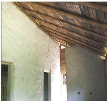
**Muros no estructurales:** deben vincularse con los muros perpendiculares a su plano y con los diafragmas del techo. Tendrán un ancho mínimo igual al diámetro de las guaduas usadas en los extremos iniciales y final. Se recomienda construirlas en madera aserrada ya que sus uniones permiten mayor rigidez.
