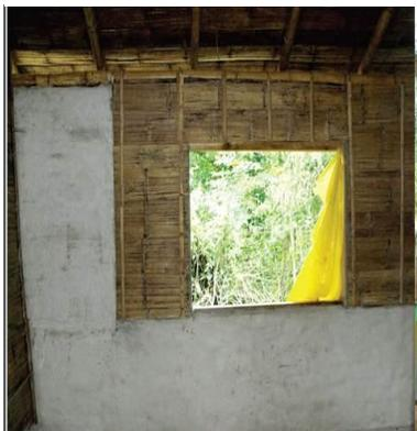
**Muros estructurales arriostrados:** compuestos por vigueta superior o solera y elementos en unión en los extremos además de los elementos de arriostres inclinados y recubrimiento con base de mortero con o sin estirilla o malla de guadua y colocada sobre la malla de alambre. Resiste carga vertical y fuerzas horizontales como sismos o vientos.
