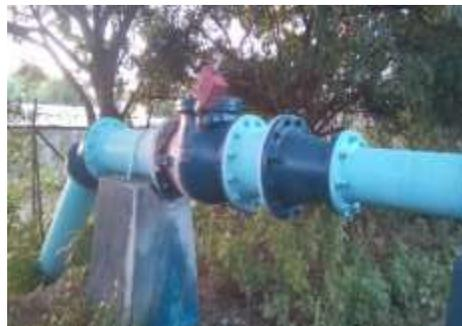
Imagen #35: válvula de retención.
