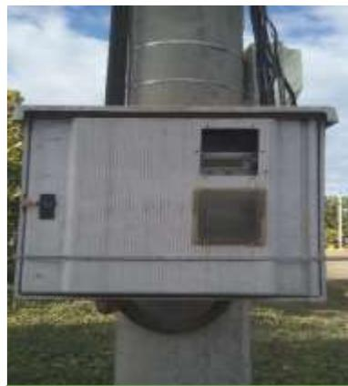
Imagen #13: medidor de consumo energía. Elaboración propia
