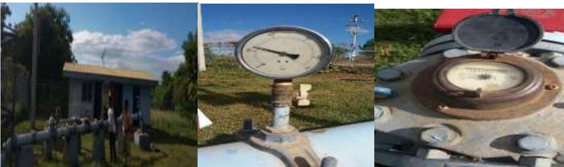
Imagen #15,16 y 17: sarta de HF de 6", manómetro, y medidor de caudal
