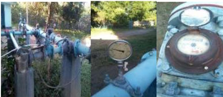
Imagen #25, 26 y 27: sarta de HF de 6", manómetro y medidor de caudal.
