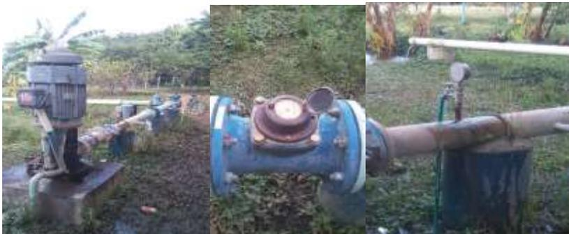
Imagen 7,8, y 9: sarta de hf de 6", medido de caudal y manómetro respectivamente. Fuente: elaboración propia.
