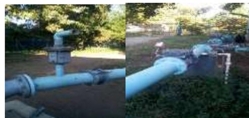
Imagen #28 y 29: válvula de aire y de retención. Fuente: elaboración propia
