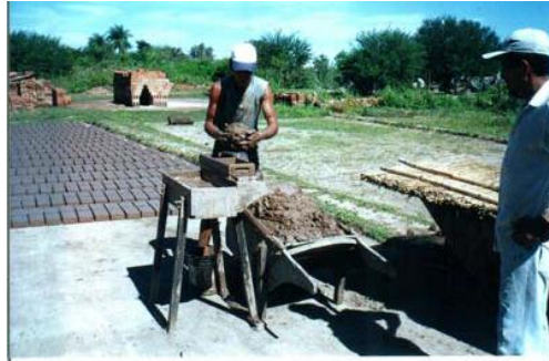
Figura no. 3 moldeado de los ladrillos
