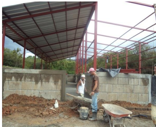
Foto 3. Construcción de la planta para la realización del proyecto
