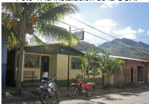
Foto 1: la instalación de la UCA.
