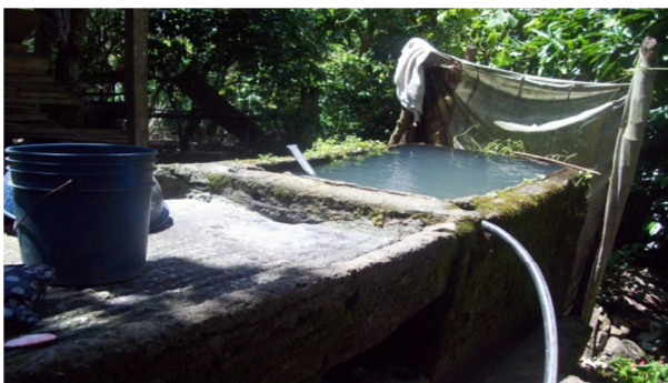
Foto 6 Pilas de almacenamiento del agua.
