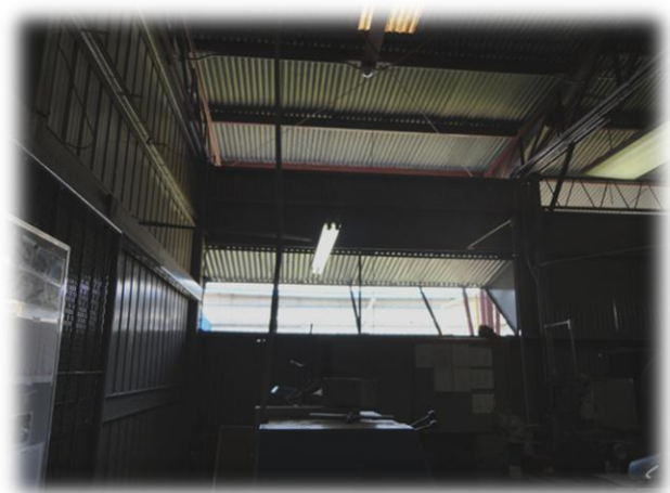
Ilustración 16: Vista interna de pared norte. Fuente propia
