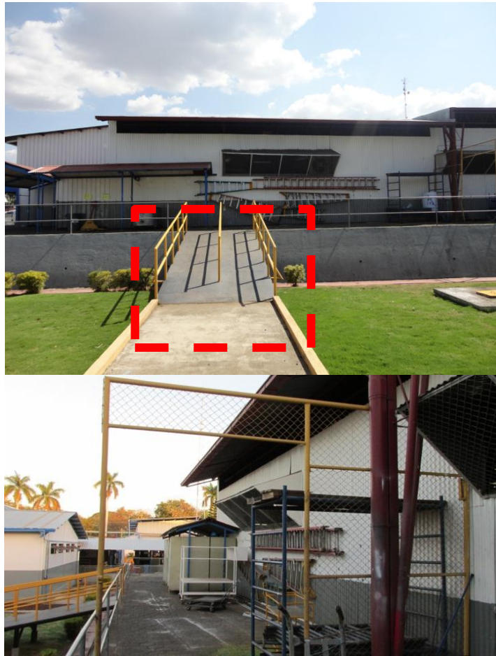
Ilustración 30: Rampa de acceso número 2 conexión nave de producción/ Pasillo de acceso hacia producción.
