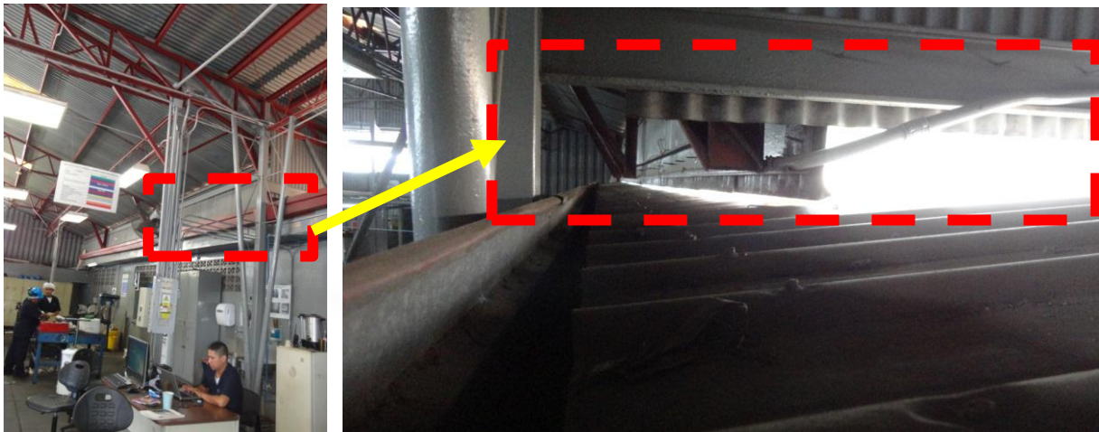
Ilustración 17: Estructura de cerchas existentes
