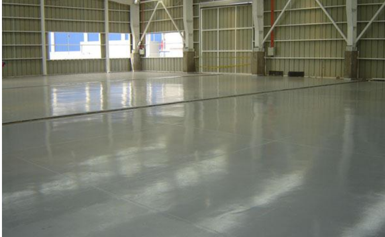
Ilustración 47: Resultado de la aplicación de pintura epóxica en losas. Fuente Wikipedia
