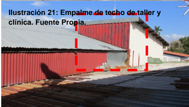
Ilustración 19: empalme entre techos de taller. Fuente Propia.
