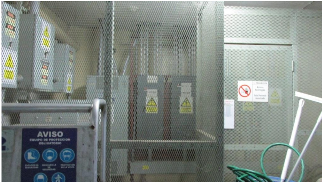
Ilustración 27: Cuarto de paneles Existente. Fuente propia
