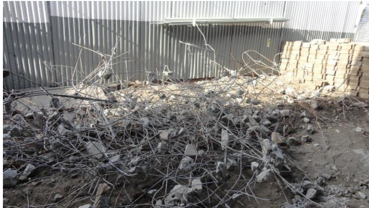
Ilustración 24: Demolición de losa. Fuente propia
