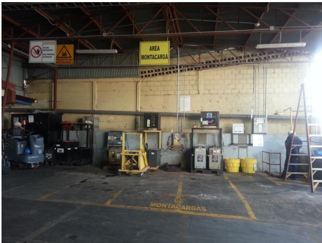
Ilustración 27: Cuarto de Baterías Existente. Fuente propia
