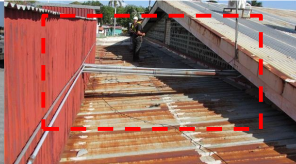
Ilustración 20: Unión de techo de Bodega de Repuestos y Pared de edificio Administrativo. Fuente Propia.
