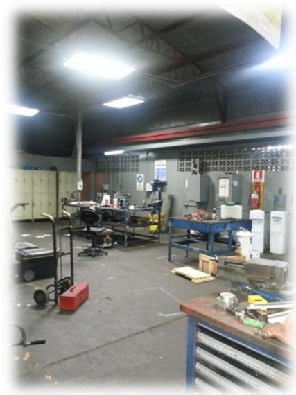
Ilustración 23: Estado de losa de Taller. Fuente Propia.
