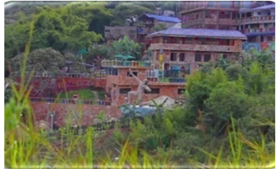
Ilustración 24. Zona Occidental Edificio de 4 Pisos y Habitaciones
