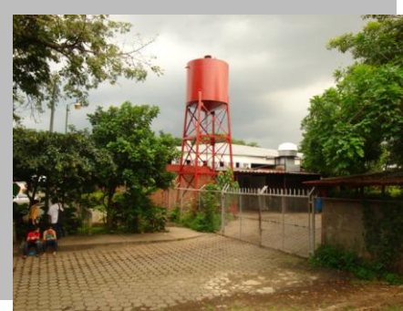
Fotografía 13: almacenamiento de agua potable
