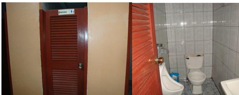
Fotografías 11 y 12: instalaciones sanitarias del comedor.
