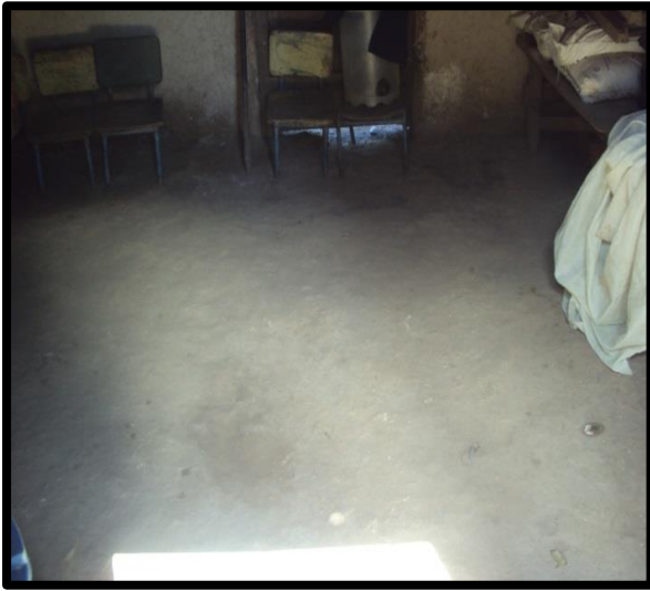
Piso de Tierra de la vivienda
