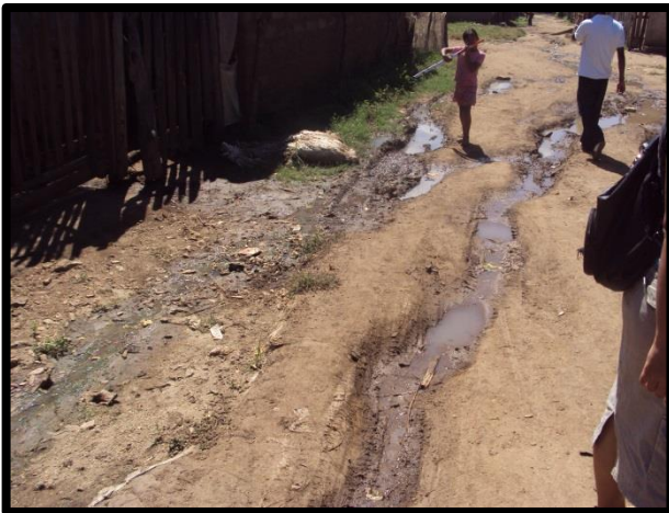
Agua residual corriendo por la calle
