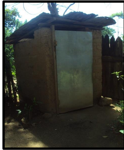
Eliminación de Excretas mediante letrina
