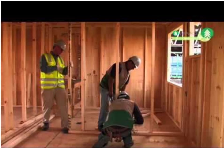
Figura 13. Casas trabajadas con mampostería de madera
