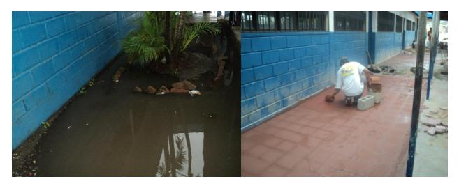
Fotografía donde se muestra el antes y el después de la remodelación de espacios ocupadas por las jardineras del centro donde se estancaba el agua de lluvias.
