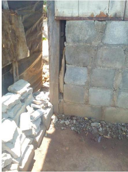
37. UNAN MANAGUA. (2014). Confinamiento de mampostería con madera rolliza. [Figura]. Fuente: Inspección realizada por la UNAN MANAGUA en el municipio de Mateare el día 17-04-2014. Departamento de construcción.
