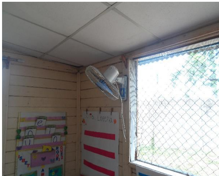
Ilustración 4. 1 Daños Visibles en la Infraestructura del Centro Preescolar de Aplicación Arlen Siu Fuente: Elaboración Propia.
