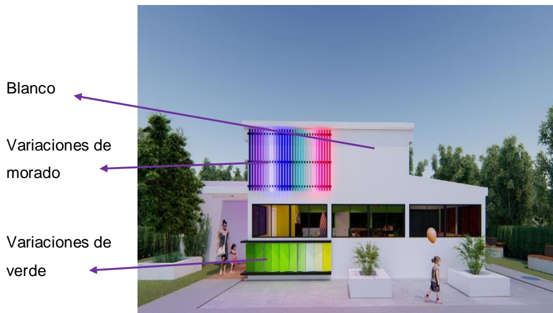
Ilustración 4. 34 Colores en Fachada
