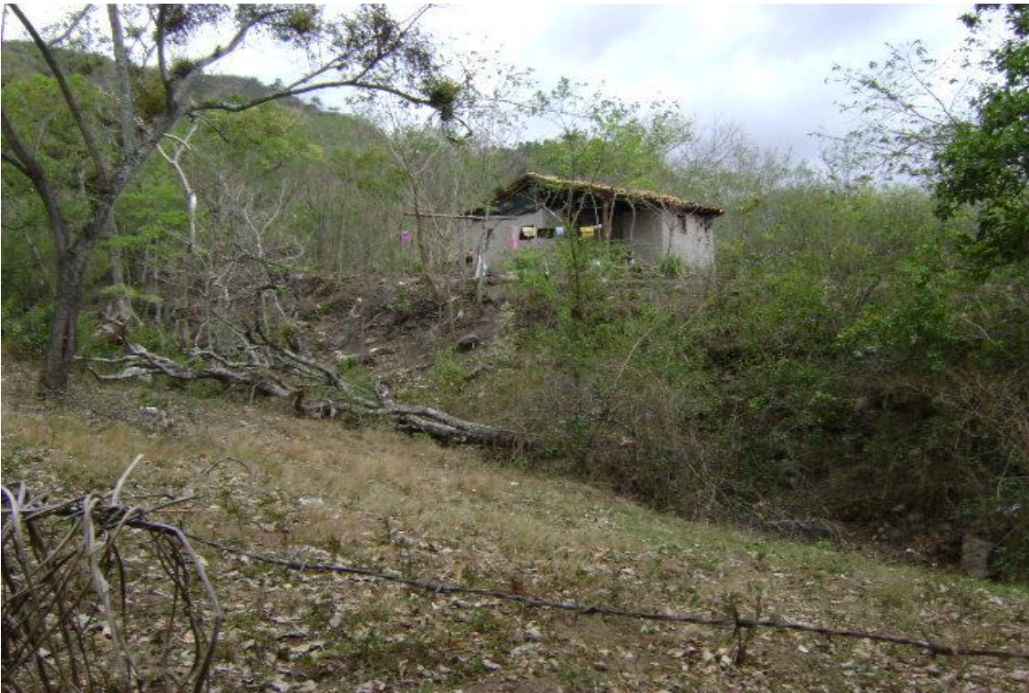
Foto 6: Infraestructura de la vivienda
