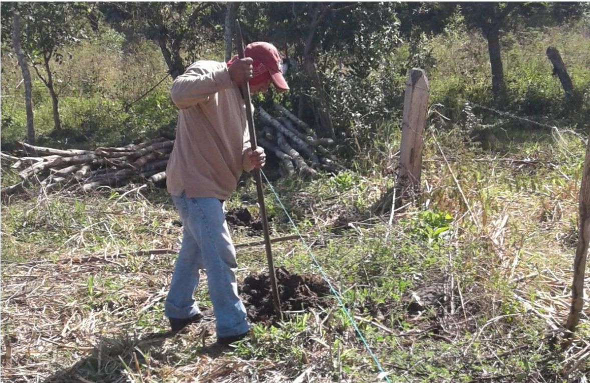
Ilustración 4. Excavación de hoyos
