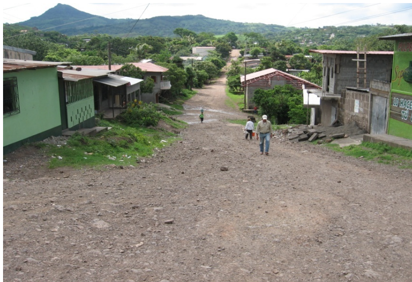
Estación 0 + 448.11 del eje 2, en la avenida 1, Terminación del Proyecto Punto más elevado del Proyecto - Dirección Sur – Norte
