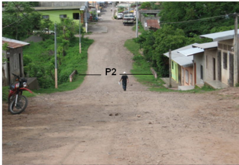
Eje 5, Puente 2- Dirección Este –Oeste.
