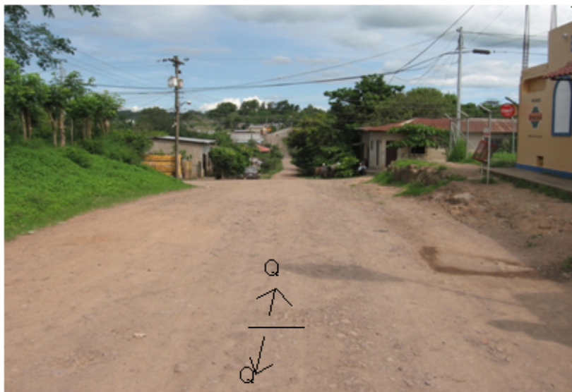
Parte aguas sobre el Eje 2, en la avenida 2, Dirección Norte sur
