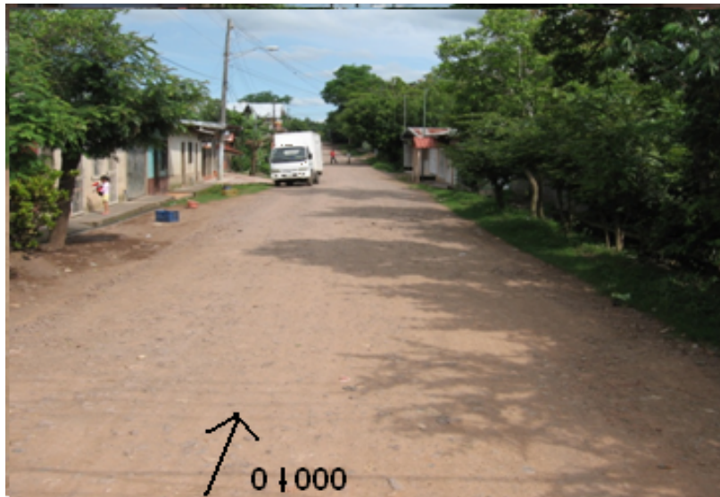
Estación 0 + 000, en la avenida 1, inicio del eje 2- Dirección Norte - Sur
