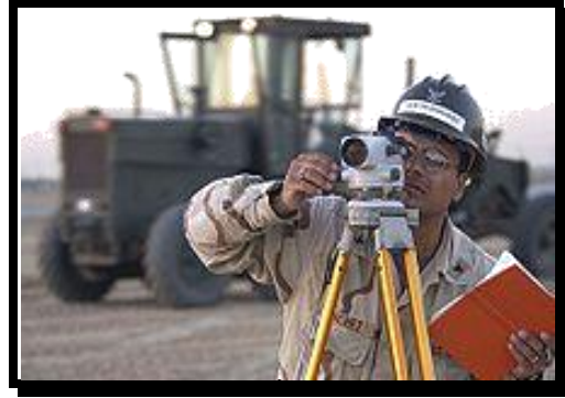
Fig. 3 Operario usando instrumento de nivelación.
