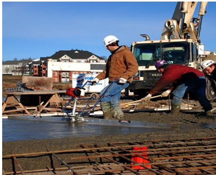
Ilustración 16. Conformación de concreto con codal Vibratorio
