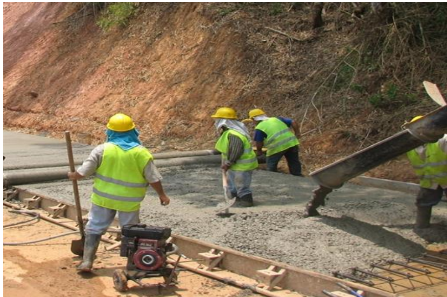
Ilustración 15. Cuadrilla colocadora de Concreto Hidráulico
