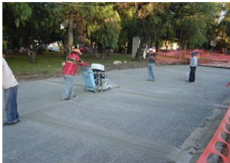
Ilustración 18. Cortes y modulación en la losa
