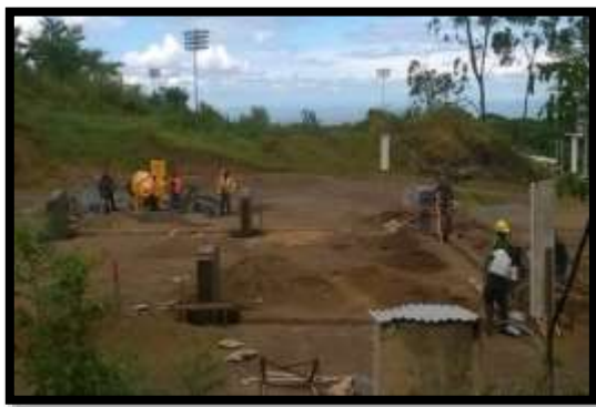
Fotos 40. Trabajo de Colocación de Zapata y Pedestal.
