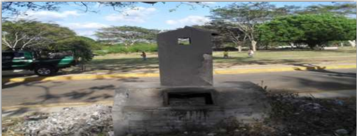
Fotos 3. Incinerador de Residuos artesanal ubicado en la Facultad de Ciencias Médicas (Propia).
