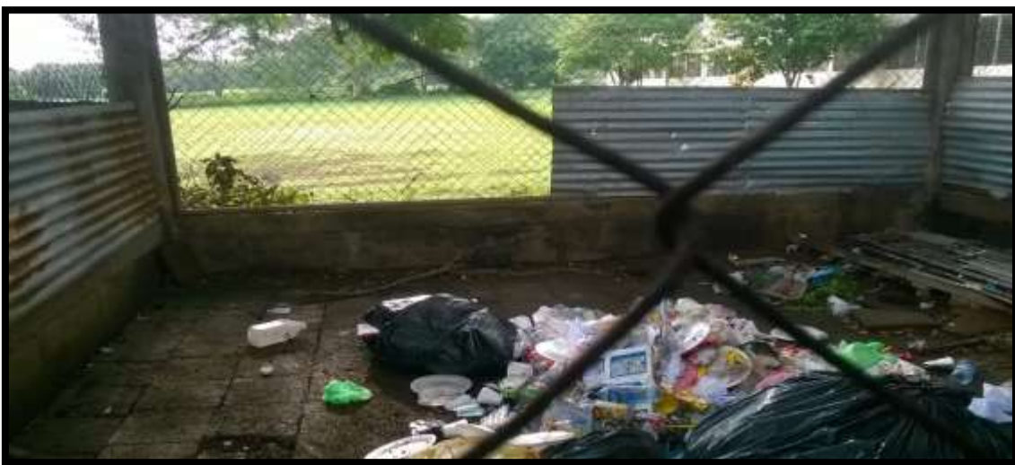
Fotos 19. Sub- estación de transferencia ( la Perrera), cerca del pabellon de Medicina (propia)
