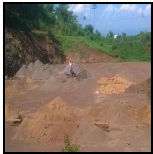
Fotos 41. Etapa de Construcción de pedestales sitio de ubicación de Planta de Transferencia.
