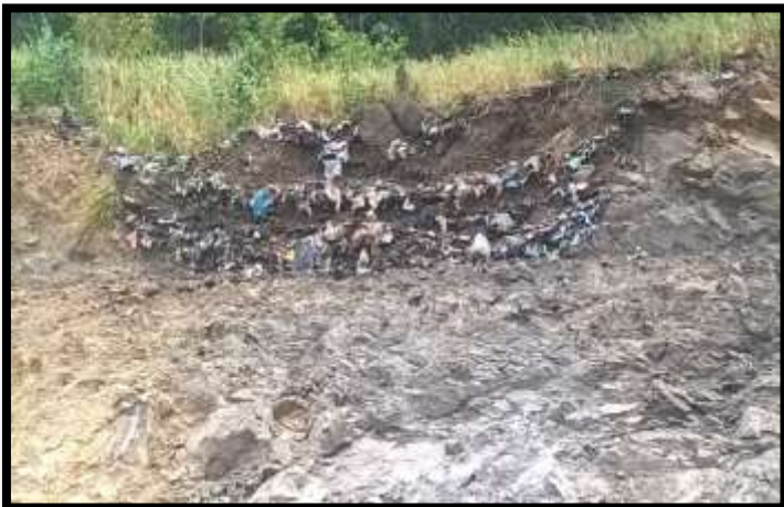
Fotos 31. Antiguo Botadero y recubierto posterior con material.
