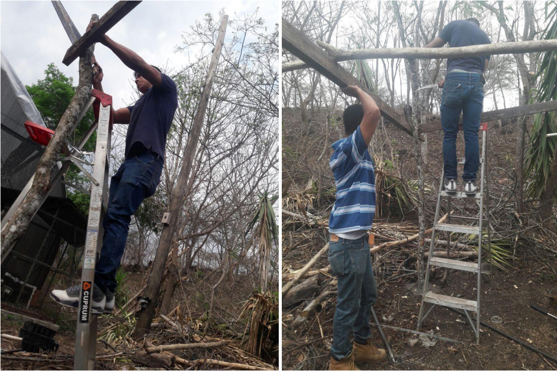
Fotos. 1 y 2. Elaboración de la caseta para la implementación del experimento.
