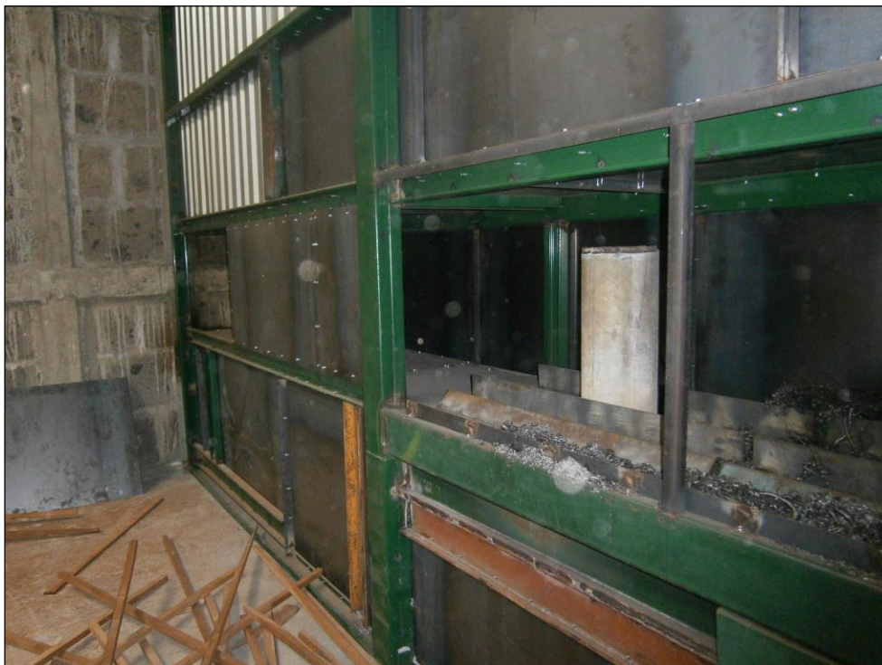
Figura 24. Caldera térmica para el aprovechamiento de los residuos biomásico.
