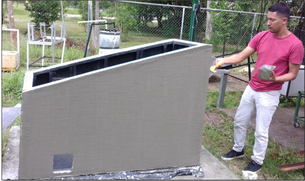
Figura 14. Revestimiento del prototipo.
