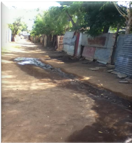
Figura N° 9. Fotografía de los andenes del sector tres del barrio Hugo Chávez Fuente: elaboración Propia de las investigadoras.
