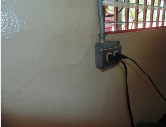
Imagen 11 pocas fuentes de energía, conectados directamente por fuera de la pared.
