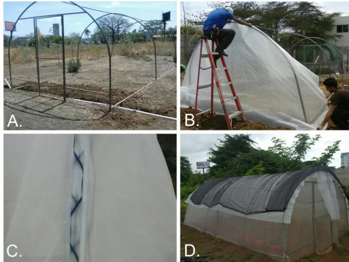
Figura 29. Invernadero tipo Túnel Individual, A. Marco de hierro galvanizado, B. Recubrimiento con malla antiviral, C. Tensado con Lockers y Zigzag, D. Colocación de plástico y malla sarán.
