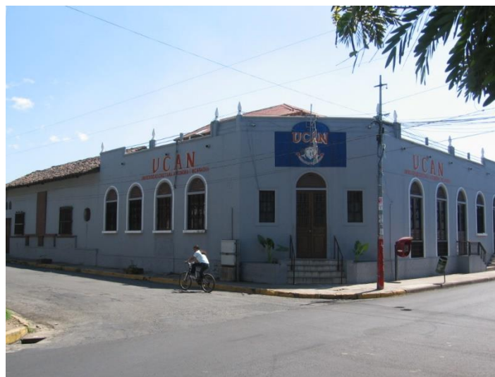
Instalaciones Sede UCAN - Chinandega
