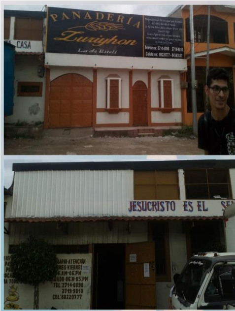
Imagen N° 29 Exterior del local
