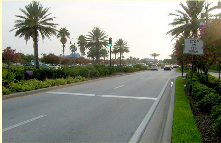
Figura 7: Rotonda semaforizada en Florida, USA
