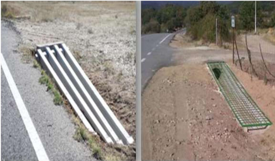
*Ilustración 30. Propuesta de protección para el drenaje longitudinal.*
