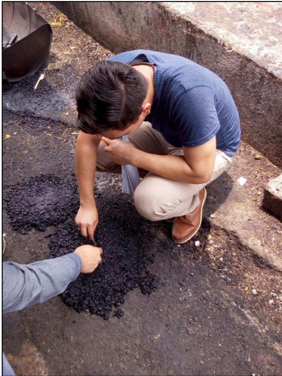
Figura 20: Inspección de humedad en mezcla.
