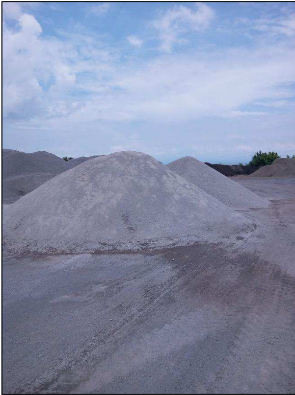
Figura 23: Acopios de material pétreo.
