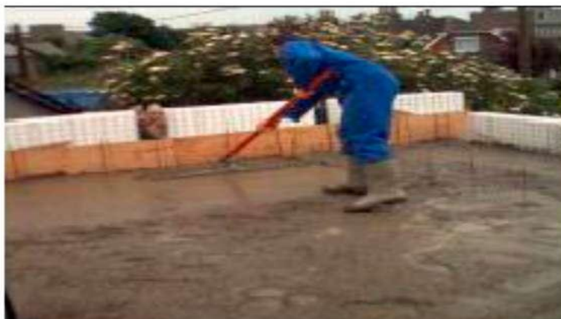
Foto # 24 Colado en losa
