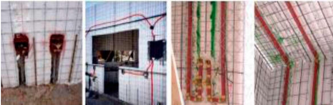
Fig. #20 canalizaciones Disposición final de canales previa al revoque de mortero.
