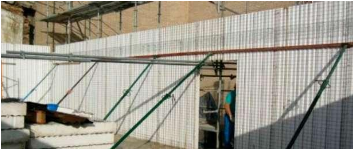
Fig. #1 ubicación de apoyos laterales
