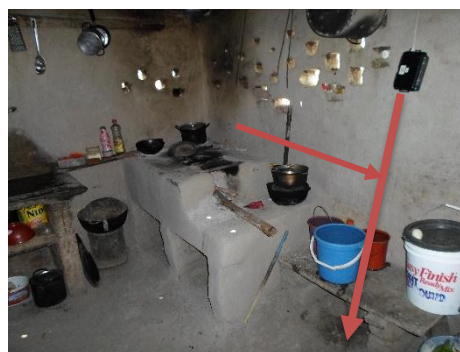
Imagen 8. Colocación de equipos
