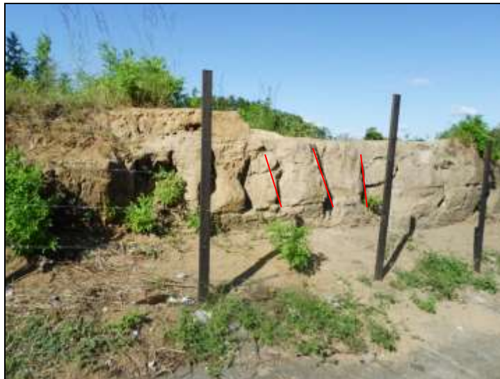
Foto 4: Corte Sur. Coordenadas E575795, N1339191.
