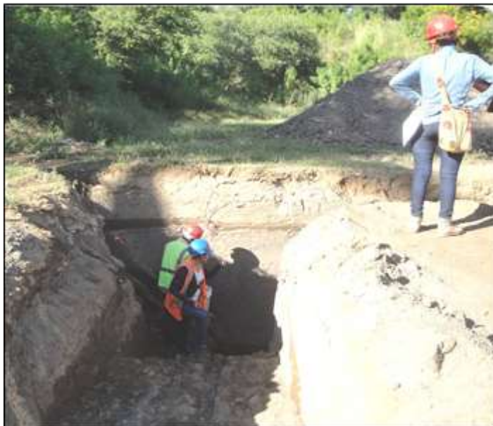
Foto 1: Levantamiento geológico de trinchera.
