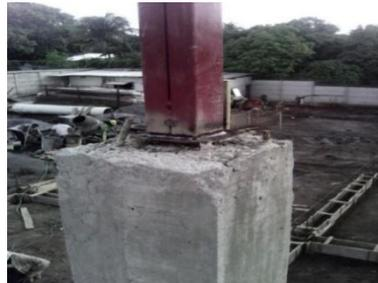
*Ilustración 4. Placa empotrada al pedestal soldada al refuerzo*
