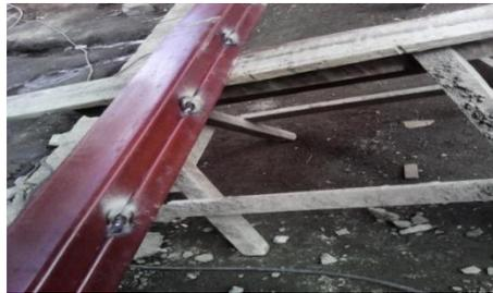
*Ilustración 1. Puntos de 2 pulgadas a cada 30 cm.*
