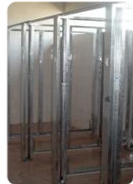
Ilustración 28 . Perfiles para paredes
