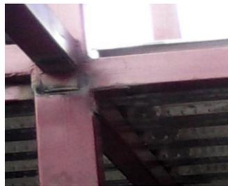
*Ilustración 5. Uniones de vigas y columnas*
