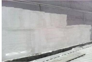
*Ilustración 39 . Pastedo de paredes Durock.*
