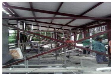
*Ilustración 41. Perfilaría para Gypsum paredes interiores.*
