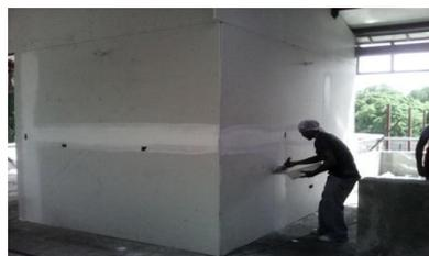
*Ilustración 42 . Pastedo de paredes de gypsum.*
