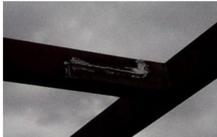
*Ilustración 2. Uniones completa soldadura corrida*
