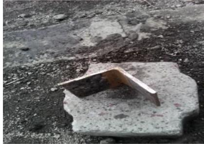
*Ilustración 3. Angular de 3 pulgadas para refuerzo en intercepciones*
