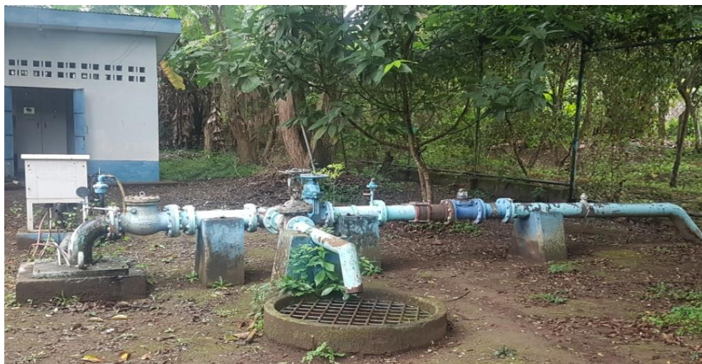
Fotografía 3. Sarta metálica de Tubería de 8 Pulgadas en P1. Fuente. Fotografía tomada por H. Ramírez
