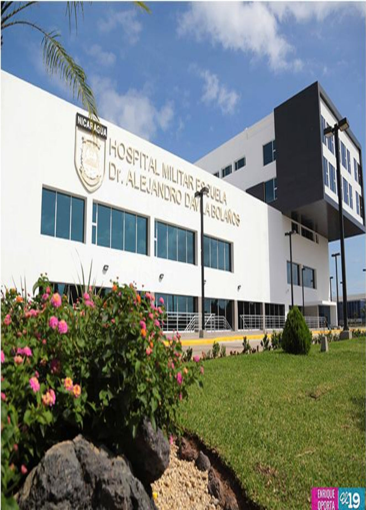
Anexo # 7. Fotos. Edificios del Hospital Militar Escuela Alejandro Dávila Bolaños.
