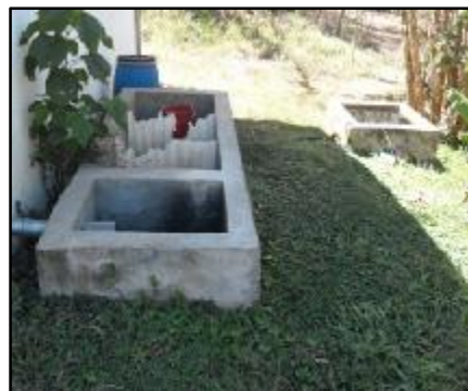
Rehúso del agua de lavandería.
