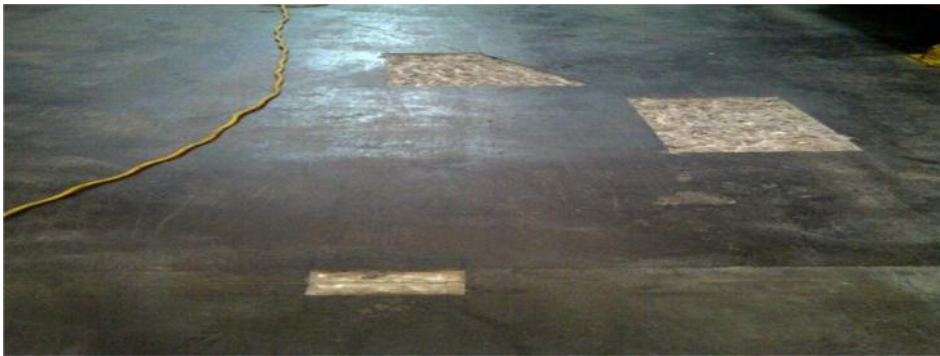
Figura 2. Mantenimiento al piso.
