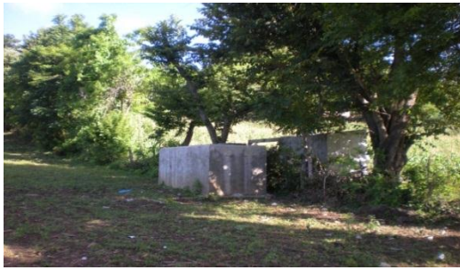
Imagen 4. (Cortinas rompe viento)
