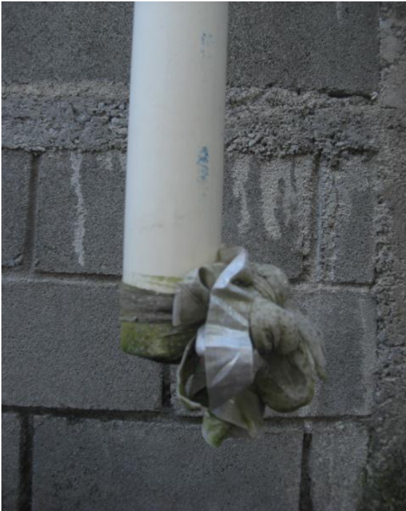
Tratamiento de pre filtración para el agua captada
