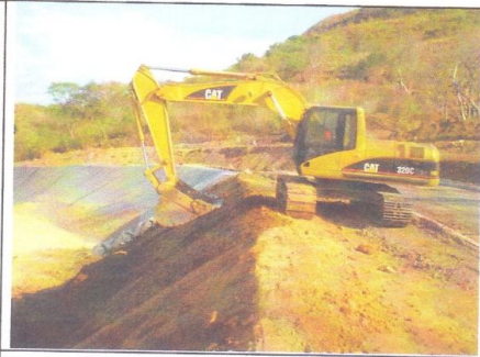
Compactación de arcilla en taludes
