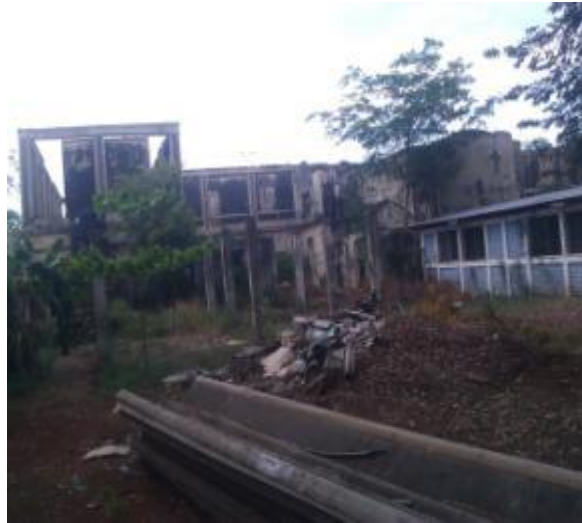
Figura 46 Vista de la parte trasera de la estructura
