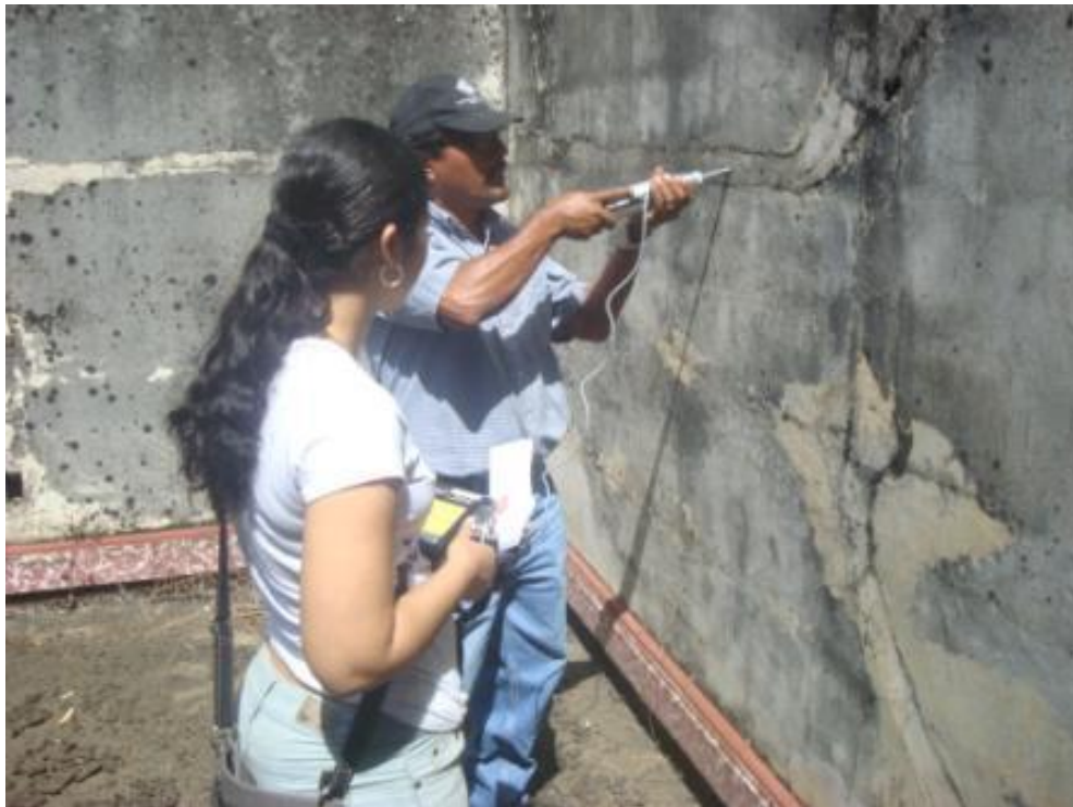
Figura 25 ensayo con esclerómetro
