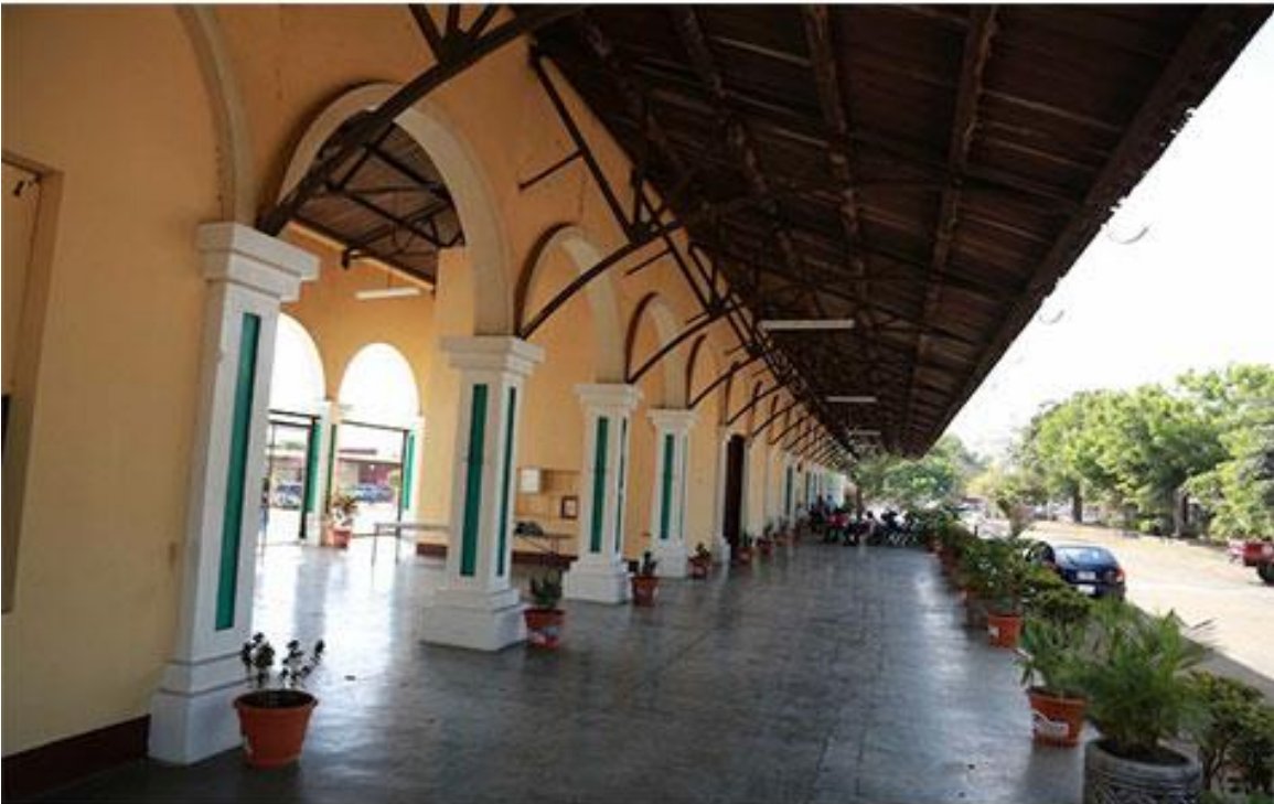
Figura 10. Antigua Estación del Ferrocarril
