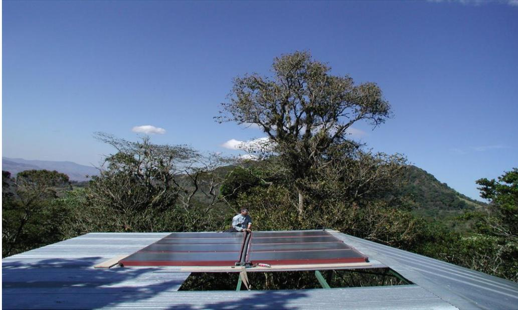
El área de captación de los 4 colectores solares es de 7.6 m<sup>2</sup> y su eficiencia teórica es de 35% esta es proporcionada por los datos del fabricante (Swissol) la radiación solar calculada es de 4.64Kw/m<sup>2</sup>día teniendo en cuenta estos datos obtenemos que los colectores solares absorben 35.26 Kw al día de los cuales aprovechan 12.34Kw los cuales son destinados a suplir la demanda de ACS.
