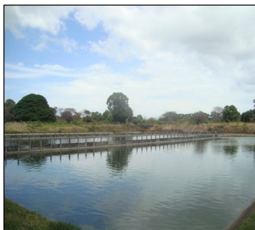
Planta de tratamiento de aguas residuales
