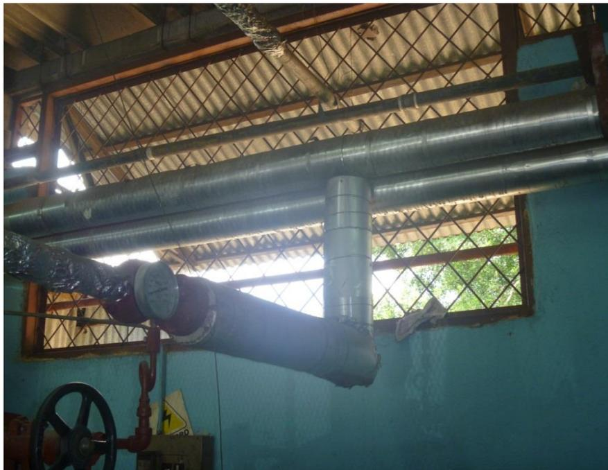
Foto 10.Tuberías de distribución y condensado del sistema de vapor.
