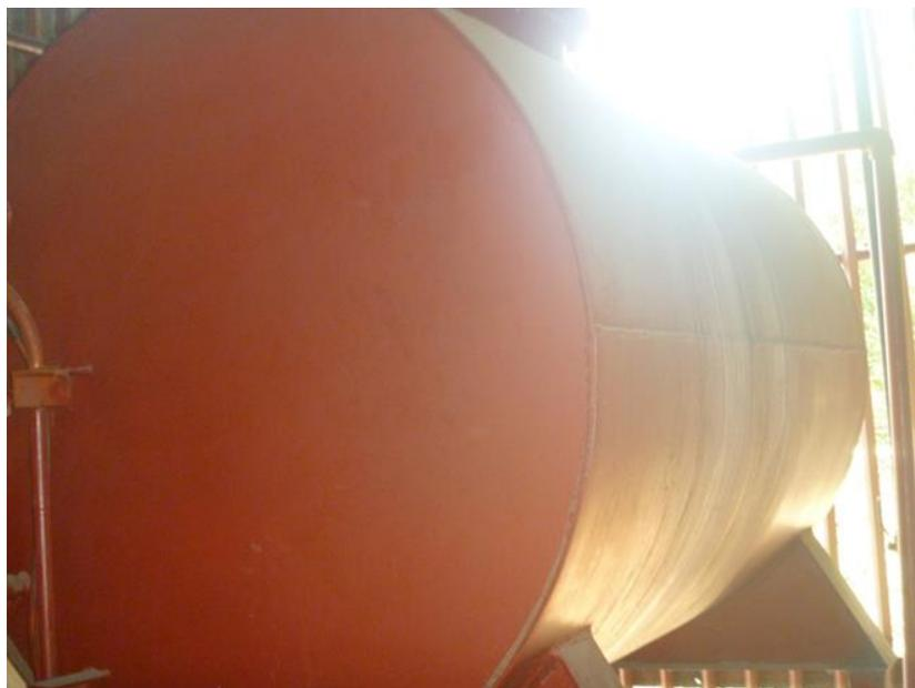
**Foto 5. Tanque de condensados.**
