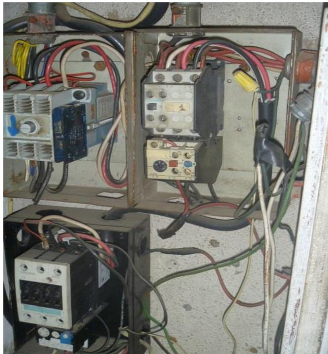
Foto 8 .Controles de arranque de bombas de agua.
