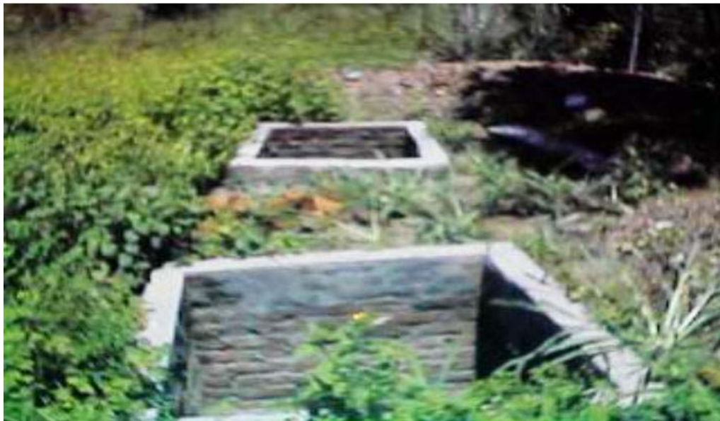
Pozos construidos recientemente para la quema de restos humanos y corto punzantes
