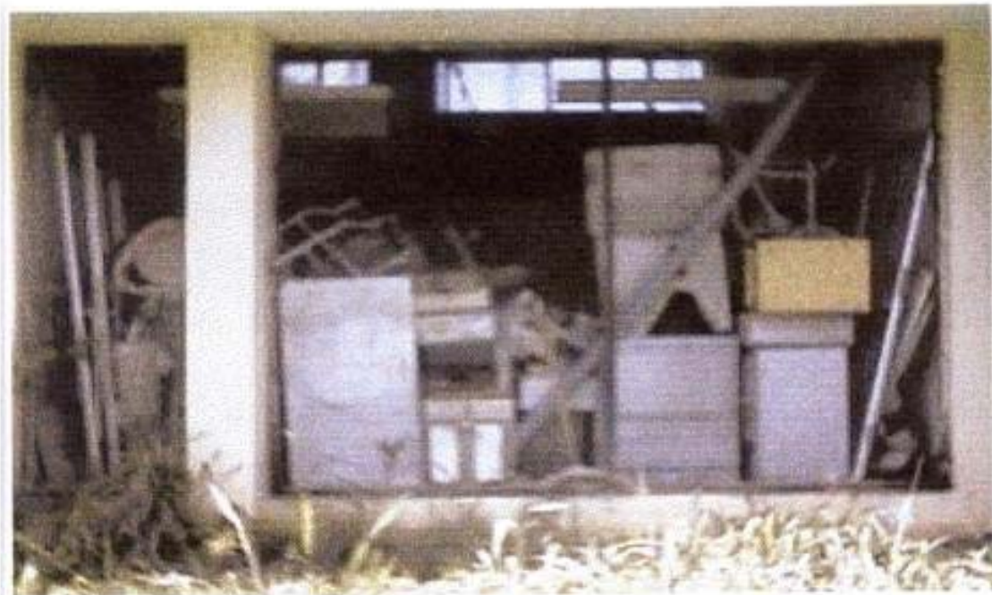
Chatarra junto al incinerador descompuesto
