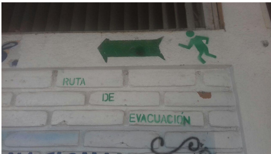
Foto 10. Señalización para evacuación
