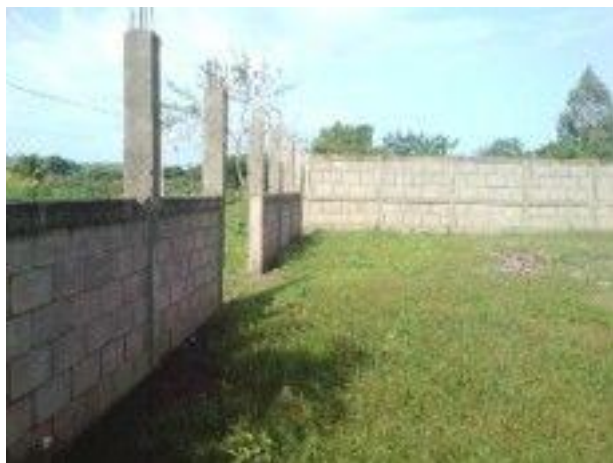
Muro perimetral de piedras canteras.
