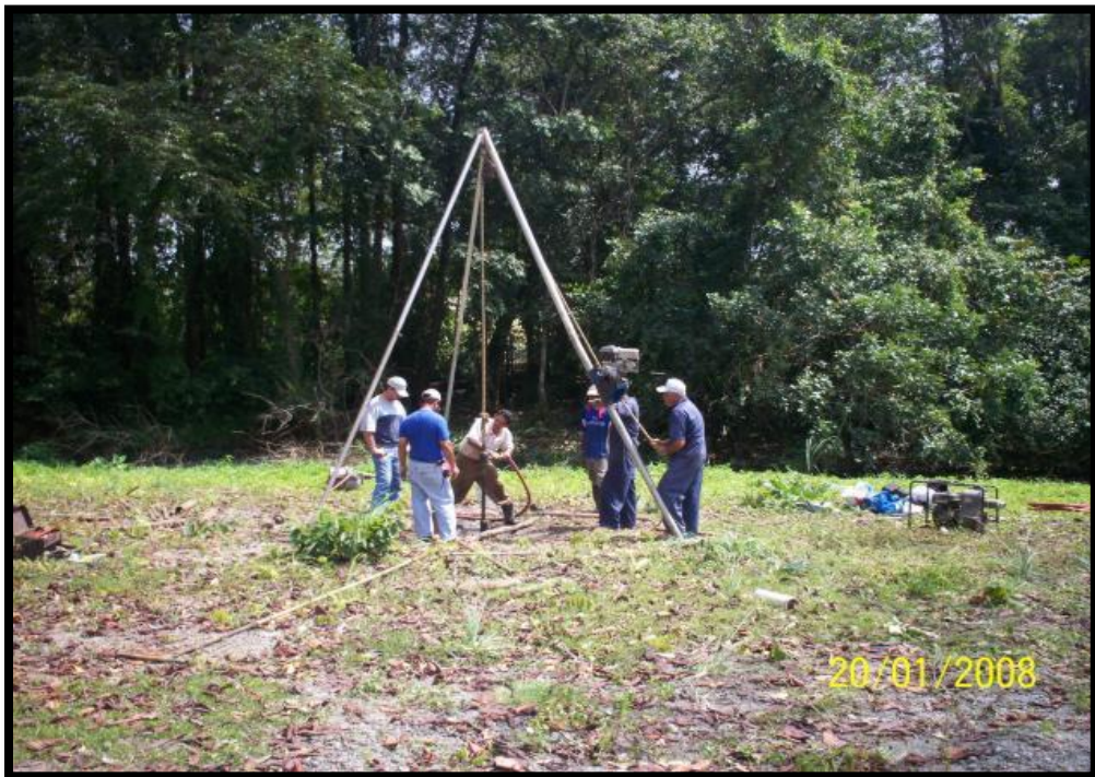
Figura 2: Realización de la prueba de penetración Estándar
